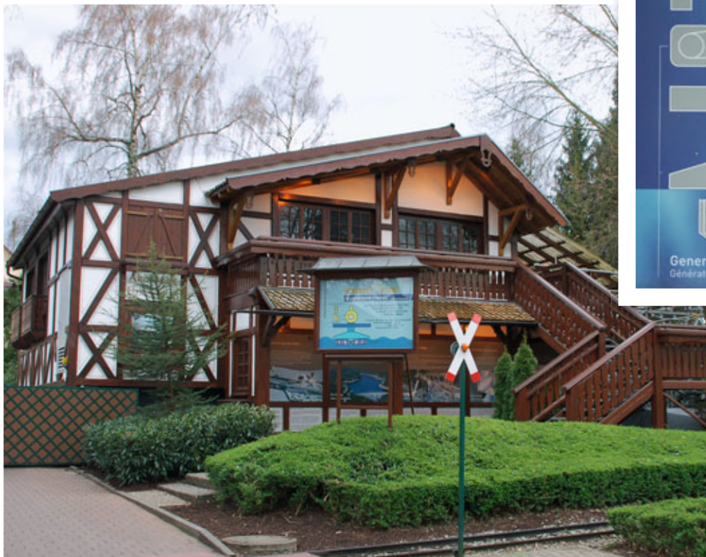
Das Wasserkraftwerk ist nahe dem Märchenwald zu finden.
